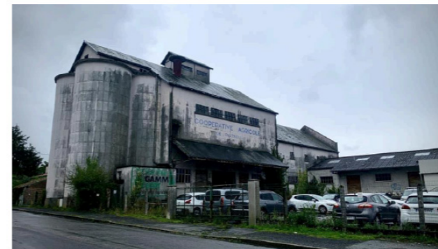
Les anciens silos doivent être conservés dans le projet et rénovés. © (Photo NR)
