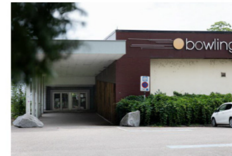
Le chantier doit démarrer par du désamiantage dans les prochains jours. Photo Roméo Boetzié
